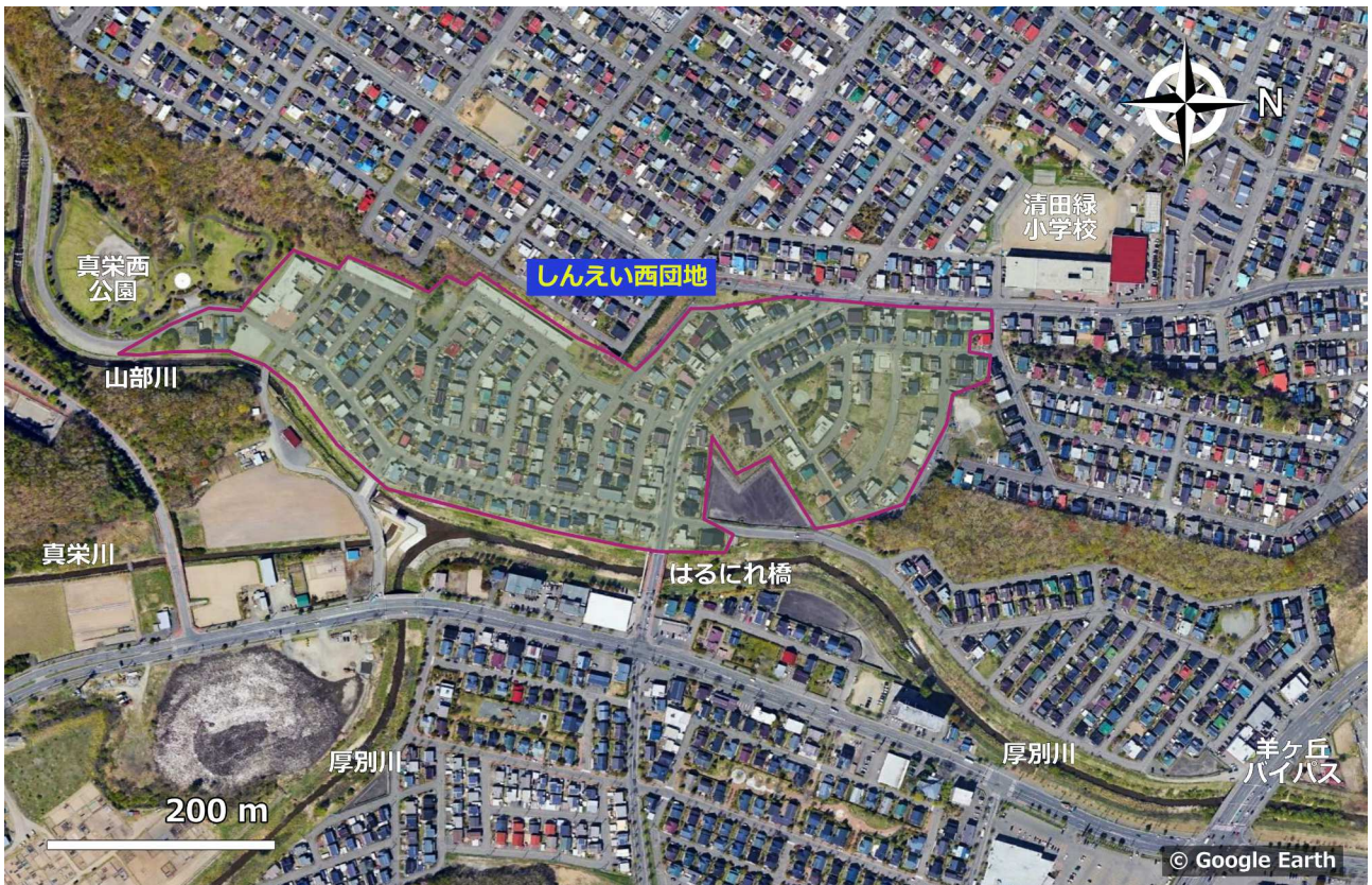
図3 しんえい西団地を真上から見た平面写真。Google Earth による。
